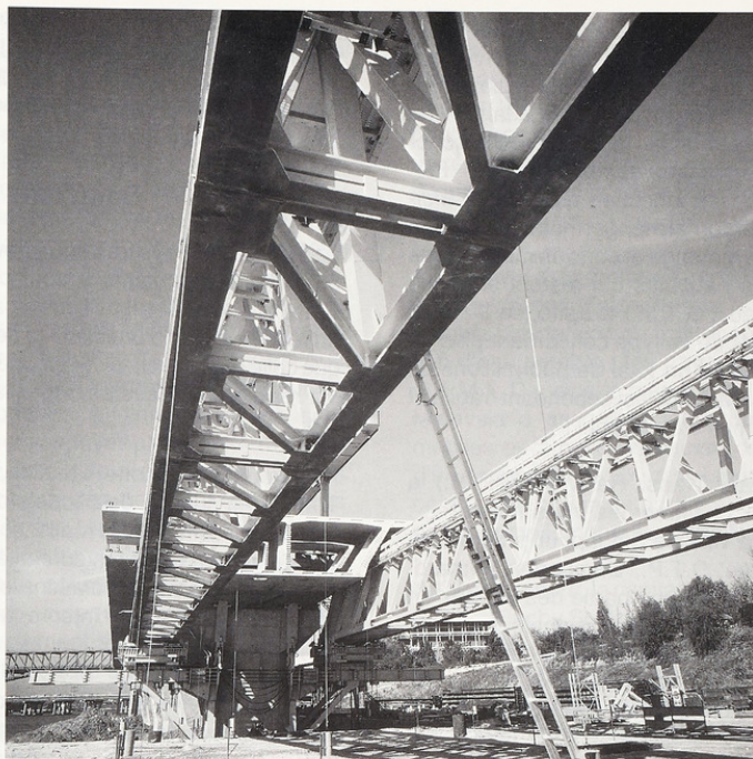
Fig. 5 - Le viaduc de Riverside à Séoul Document Freyssinet-International
