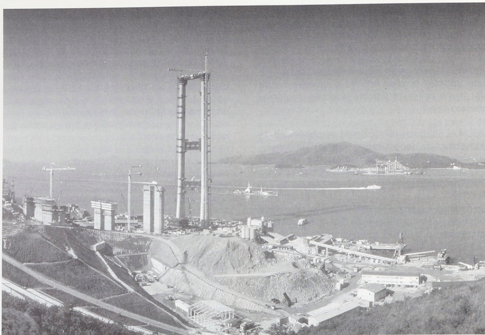
Fig. 3 - Les pylônes du pont suspendu de Tsing-Ma à Hong-Kong. Document Bouygues
