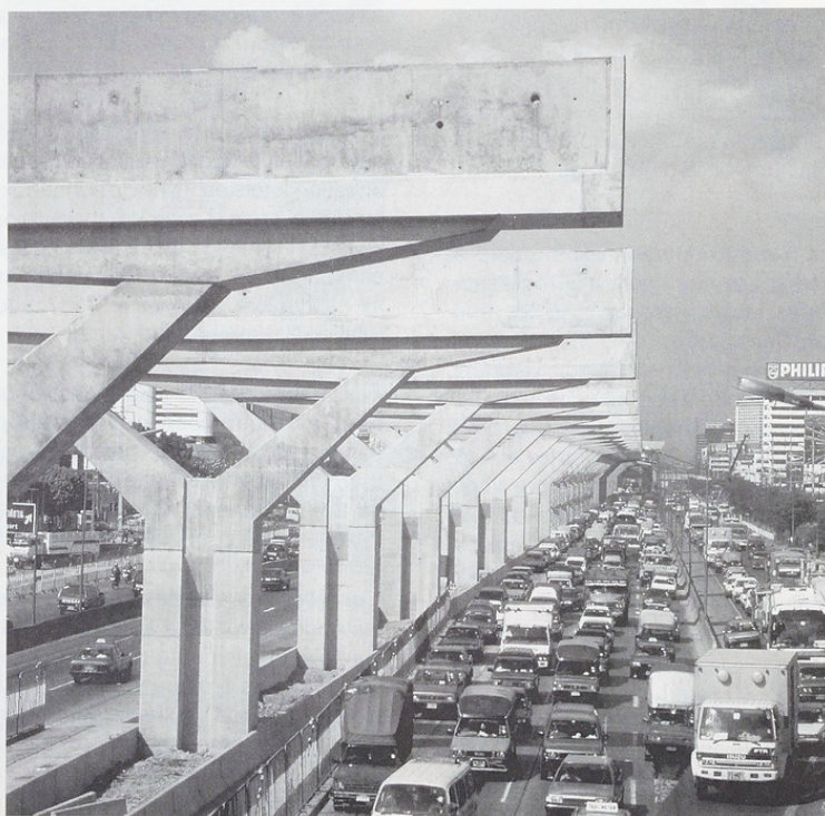
Fig. 4 - L'autoroute surélevée Don Muang Tollway à Bangkok Document G.T.M.I.
