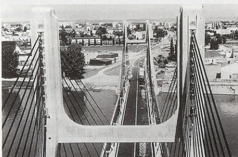
Figure 5 : L'ancrage des haubans en tête des pylônes du Pont de Bourgogne (photo G. Forquet).
