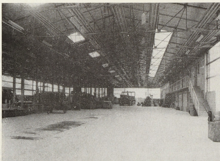
Vue générale des ateliers de dépannage et d'entretien.
