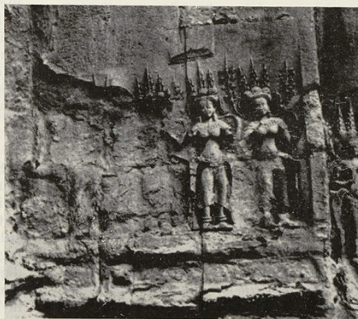
22. ANGKOR VAT (Cambodge). — Deuxième enceinte. — Tour d'angle N.-E. — Façade O. — Grès gris. — Lésion en plaque très évoluée. (Cl. Lebon, Nguyen van Anh) in Th.-J. Delvert.
