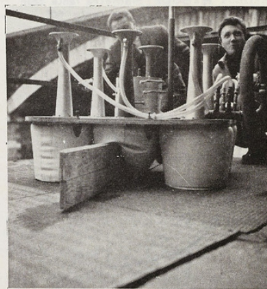
FIG. 14. — Etude du passage d'obstacles sur le modèle réduit « Terraplane » à six jupes (1960).
