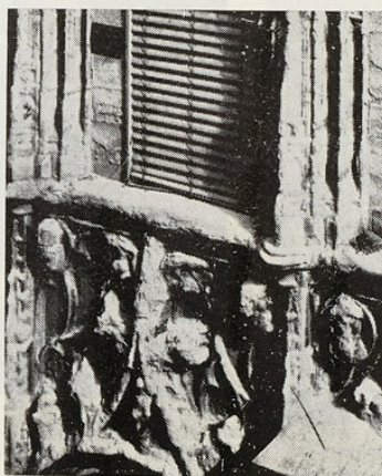
2. VALENCE (Drôme). — Maison des têtes (XVI e s.). — Molasse du Vindobonien. Erosion de surface (Cl. Bertheliet).
