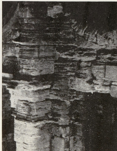
3. ARLES (B.-du-Rh.). — Arènes gallo-romaines. — Molasse du Miocène sup r . — Erosion en strie (Cl. Bertheliet).
