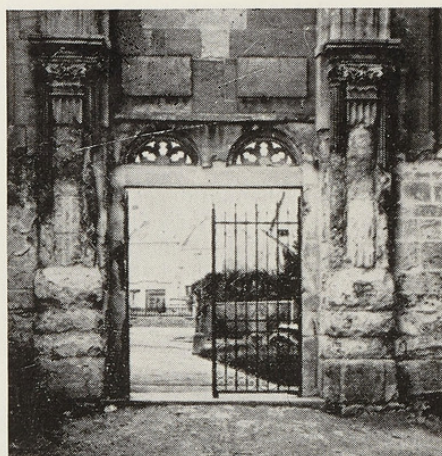
10. CERGY (S.-et-O.). — Lutétien du Bassin de Paris. — Lésion en plaque en zone de remontée d'eau (Cl. Berthelier).
