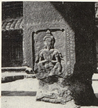
19. ANGKOR VAT (Cambodge). — Préau cruciforme. — Grès gris. — Délitage profond. (Cl. Lebon, Nguyen van Anh) in Th.-J. Delvert.
