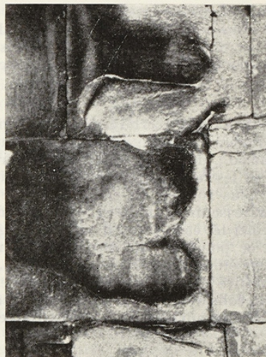
21. VAT PHNOM BAKHENG (Cambodge). — Grès gris. — Mur du soubassement. — Lésion en plaque au début. (Cl. Lebon, Nguyen van Anh) in Th.-J. Delvert.
