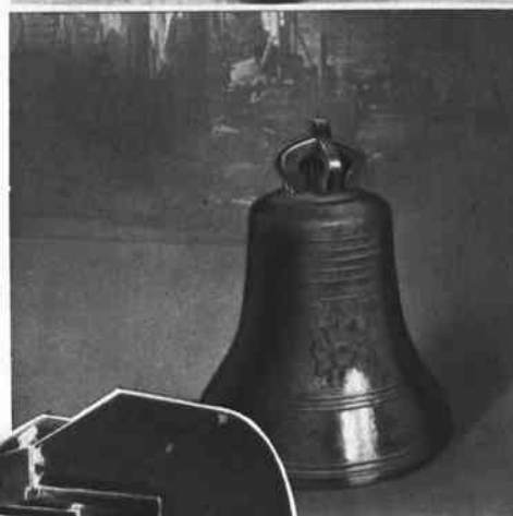
Cloche réparée par soudage
