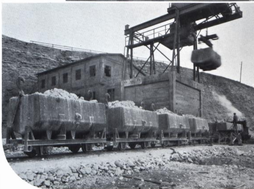
SKÅNSKA CEMENT AB, SUEDE. Wagon à chaux construit par AB Landsverk, Suède. Tare 9 tonnes, charge utile 14 tonnes.
