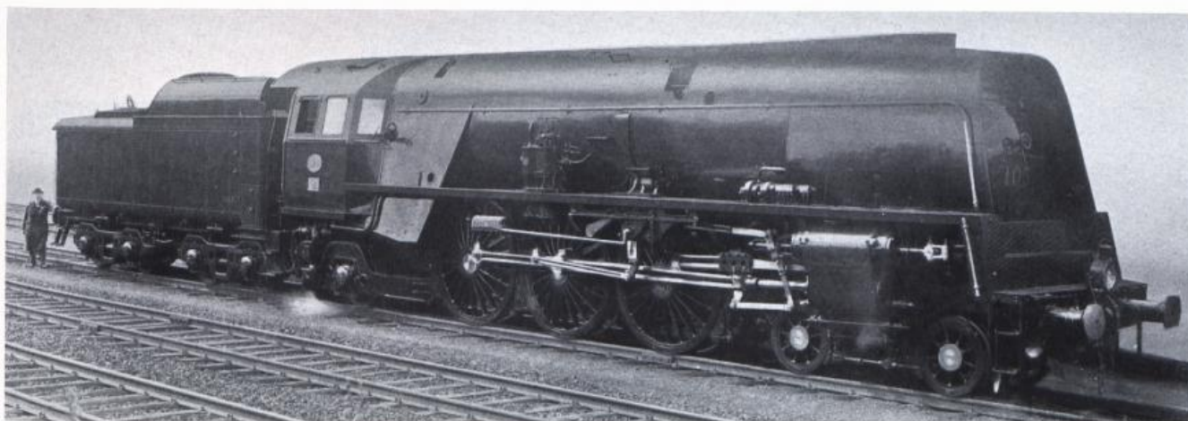
SOCIETE NATIONALE DES CHEMINS DE FER BELGES. Locomotive Pacific construite par le Consortium de Constructeurs de Locomotives Cockerill, AM Tubize, Haine-Saint-Pierre, La Meuse. Les essieux du bogie avant du bissel et du tender sont montés sur boîtes à rouleaux. Le poids total de la locomotive en ordre de marche sans le tender, est de 124 tonnes.
