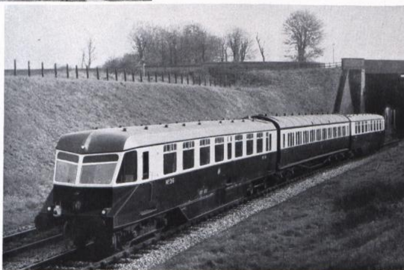
CHEMINS DE FER GWR, ANGLETERRE. Automotrice, construite par AEC, Southall, Angleterre, entièrement montée sur boîtes à rouleaux.
