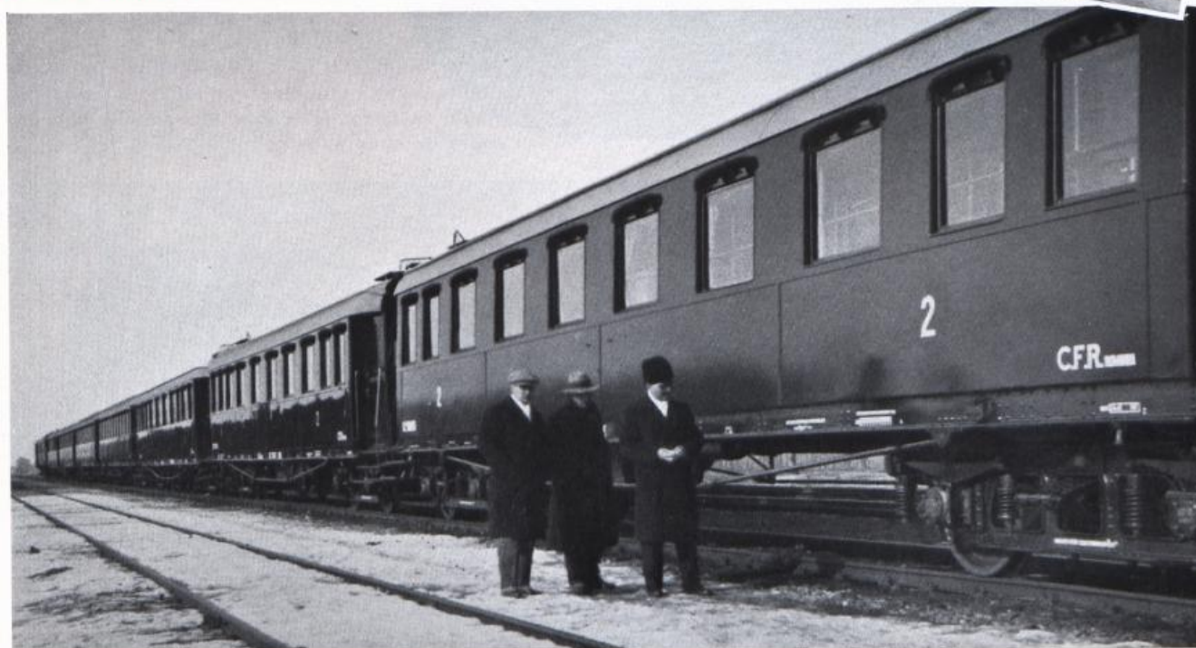
CHEMINS DE FER DE L'ÉTAT ROUMAIN. Voiture à voyageurs. Tare 38 tonnes. La figure de la page 48 montre le type des boîtes d'essieux utilisées.
