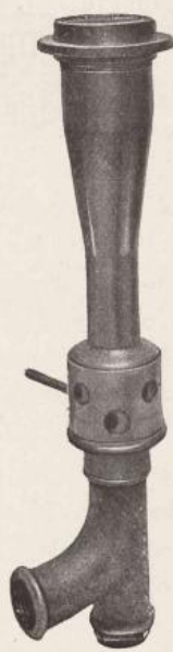
FIG. 42. Brûleur n° 6 soufflé à basse pression. (Type des n° 5 à 9, tête laiton à vis).
