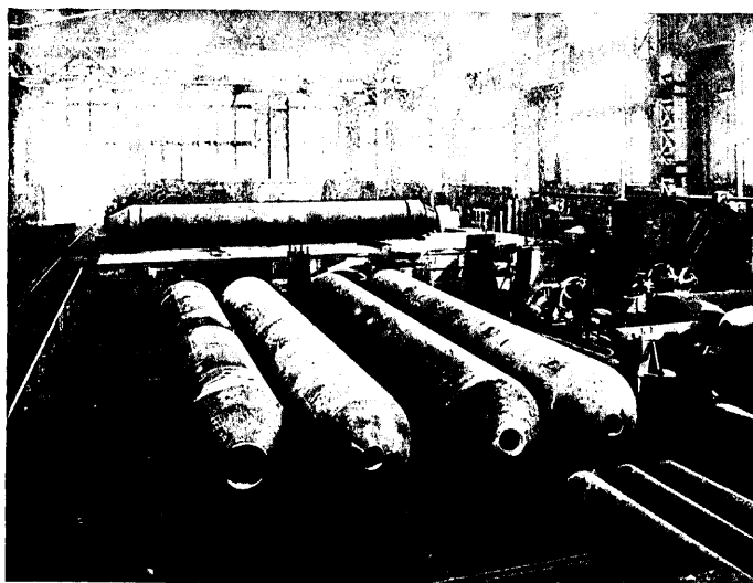
Collecteurs forgés pour chaudières à haute pression. Colectores forjados para calderas de alta presión.
