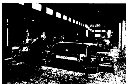
Compagnie des Mines de Vicoigne, Nœux et Drocourt. Centrale de Beuvry. Groupes turbo-alternateurs de 6.000, 10.000 et 16.000 kws. Compañia de las Minas de Vicoigne, Nœux y Drocourt. Central de Beuvry. Grupos turboalternadores de 6.000, 10.000 y 16.000 Kwat.
