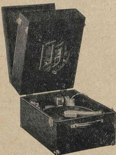
Amplificateur pour pick-up, puissance 2 watts modulés. Monté en châssis aluminium utilisant une lampe d'entrée américaine à écran de grille 224, et une amplificatrice de puissance 247 pentode, valve biplaqué 280. Filtrage poussé obtenu par deux condensateurs électrolytiques.
