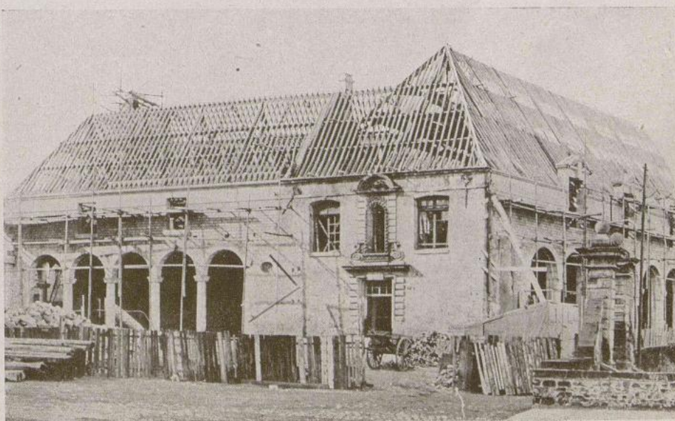
CHARPENTE DU MARCHÉ COUVERT DE LA VILLE DE LAON (AISNE). [CHARLIER, ARCHITECTE, 1930.]
