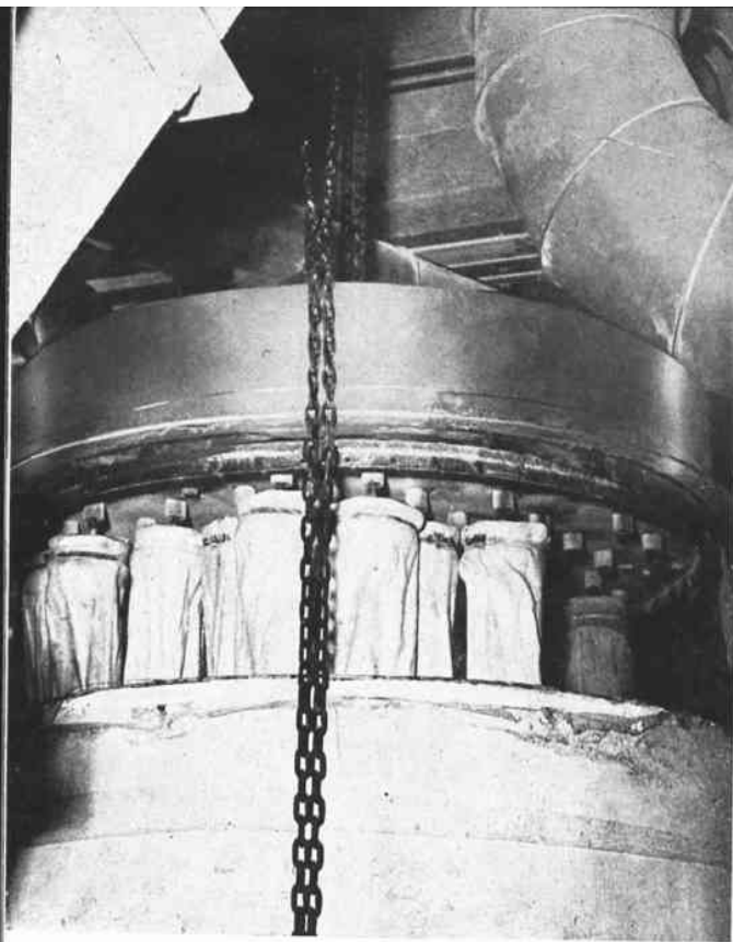
Fig. 30. — Appareil de dépoussiérage à secouage mécanique équipé en manches de Verranne (NERVUS).
