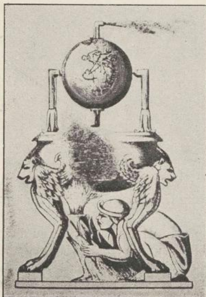
Fig. 2. Eolypile d'Héron d'Alexandrie
