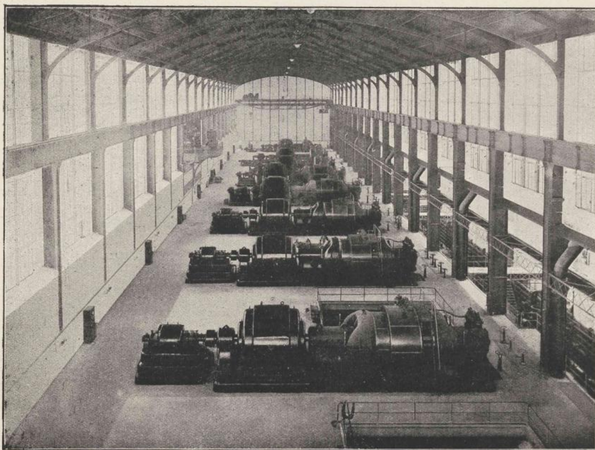
COMPAGNIE PARISIENNE de DISTRIBUTION d'ÉLECTRICITÉ (Usine Nord) à Saint-Ouen Vue de la Salle des machines comportant 5 turbines à vapeur sur huit du système « Brown, Boveri-Parsons » d'une puissance unitaire de 22.500 chevaux.
