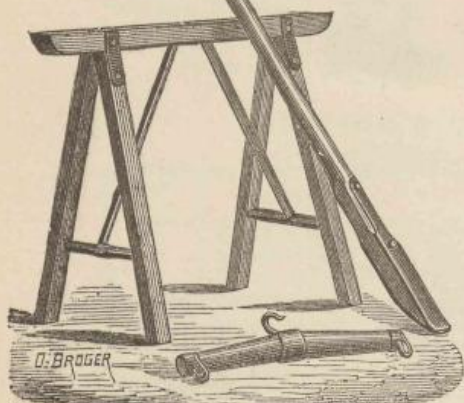
Tréteau fixe, levier, palonnier.
