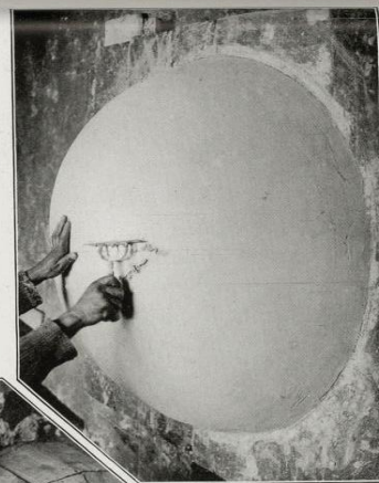
COULAGE D'UNE COUCHE DE PLÂTRE
