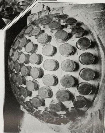
ASPECT DE LA COUPOLE AVANT LE COULAGE DU BÉTON
