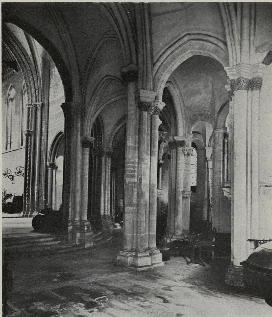
Intérieur de l'Église de l'ancien Prieuré de Saint-Martin-des-Champs.
