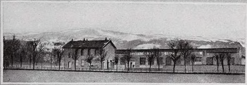
USINE DE ST MARCELLIN
