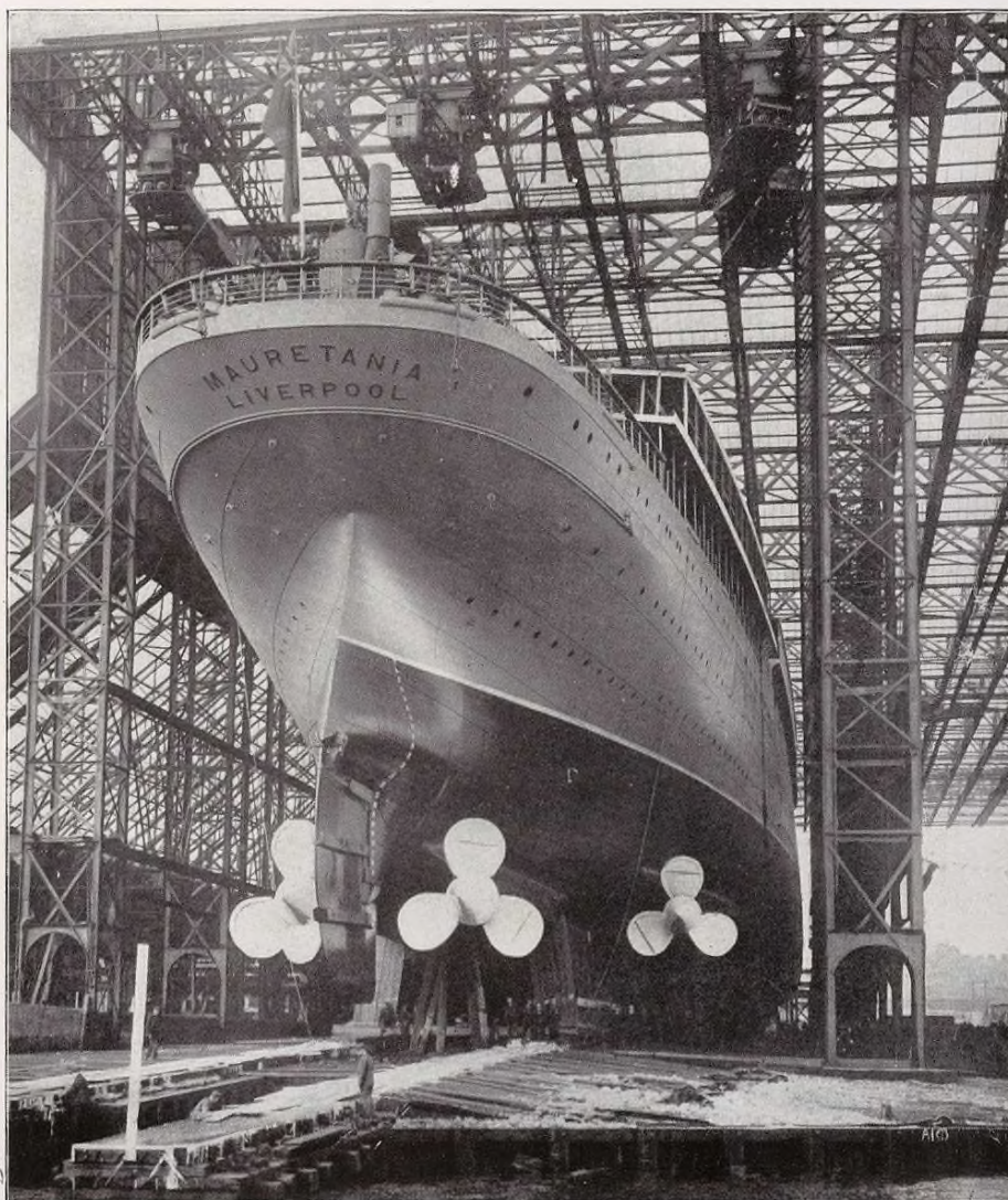
Swan, Hunter & Wigham Richardson Ltd., Wallsend. Nouvelle Cale. 20,000 mètres carrés de superficie.
