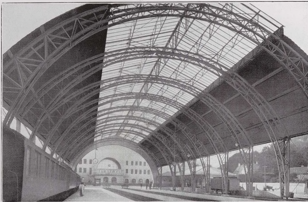
Gare de Bergen. Chemins de fer de l'Etat Norvégien.
