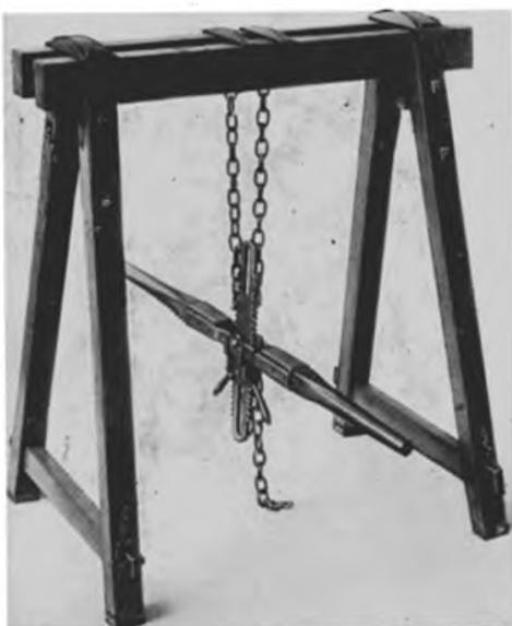
FIG. 16. — Chevrette à double levier de La Garouste (6.910)
