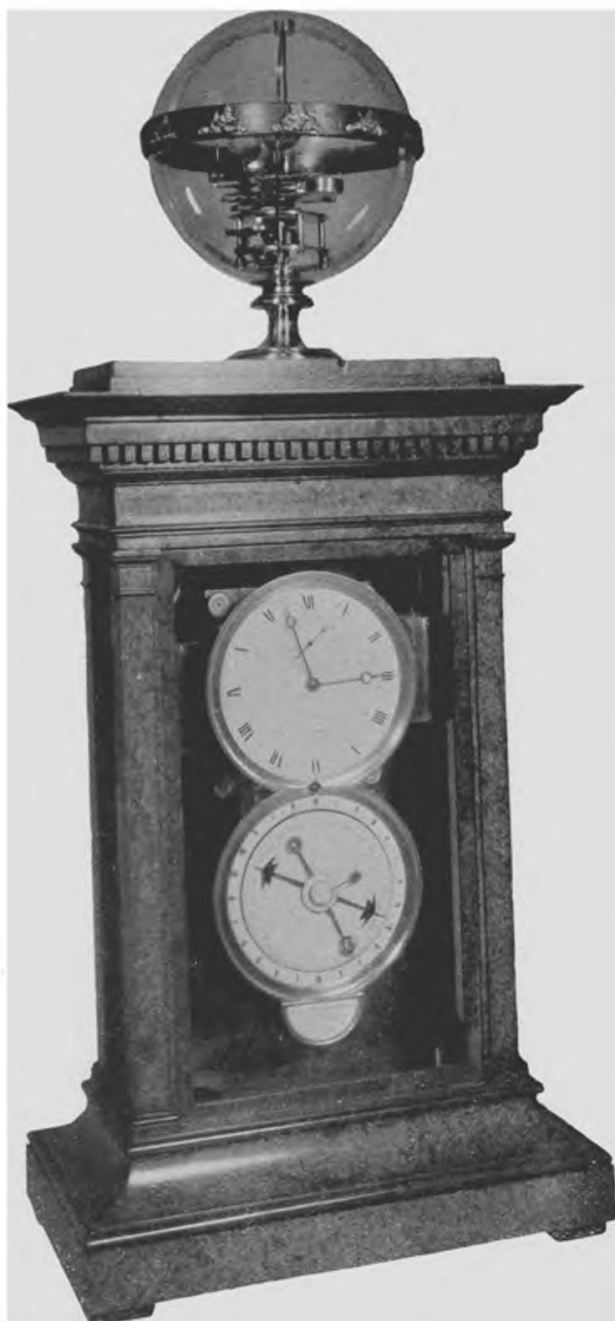
Fig. 62. — Régulateur demi-seconde astronomique avec planétaire, par Antide Janvier (17490).
