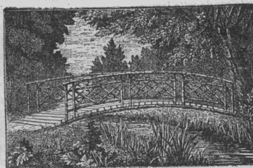
Figure 63. — Pont rustique en fer et fonte.
