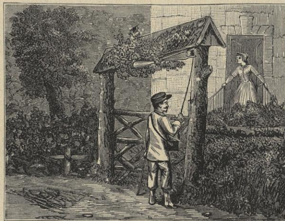
Fig. 62. — Installation économique d'un instrument d'appel pour maison de campagne.
