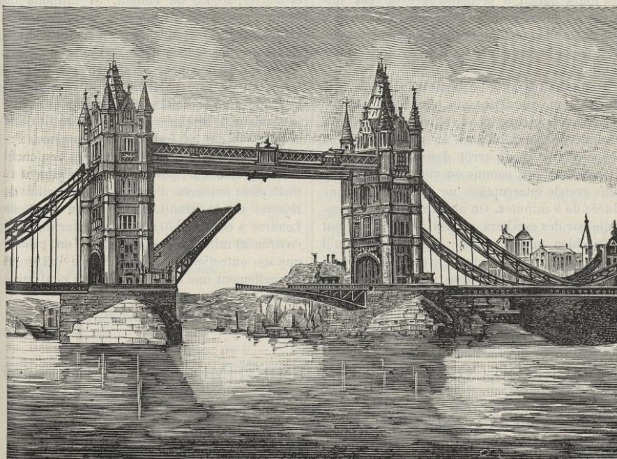
Fig. 159. — Le nouveau pont de la Tour de Londres, sur la Tamise. Vue du pont au moment où le tablier se rabaisse.
