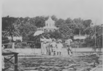
UNE PASSERELLE TROP CHARGÉE
