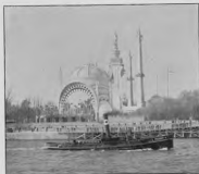
LA PORTE D'ENTRÉE MONUMENTALE DE L'EXPOSITION DE 1900 Sur la place de la Concorde, Vue de la rive gauche de la Seine (quai d'Orsay).
