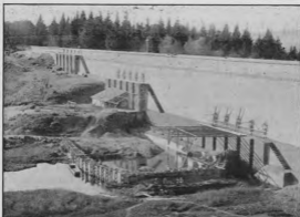
VUE AVANT DE LA DIGUE PENDANT L'EXECUTION DES TRAVAUX (DE V)
