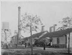
Fig. 6. — Groupe des bâtiments de la fabrication des plaques. Vu du bâtiment des réparations.
