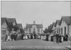
Fig. 3. — Pavillon de l'Administration de l'Usine. Vu de face, à l'extrémité de l'avenue de séparation des deux principaux groupes de bâtiments.
