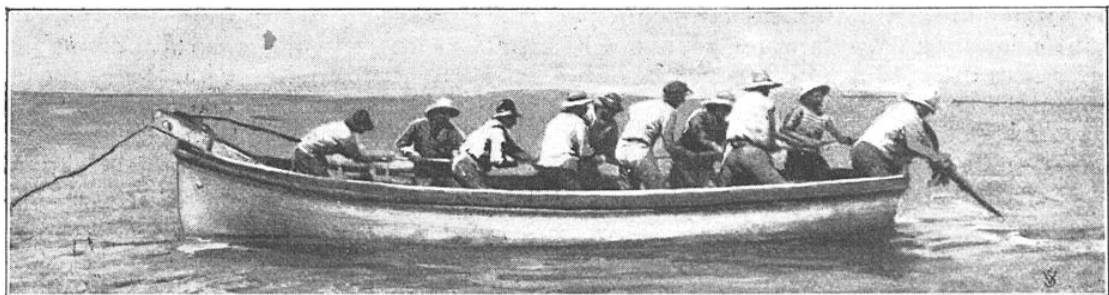
OPÉRATION DITE « PAUMOYAGE DU CABLE »
