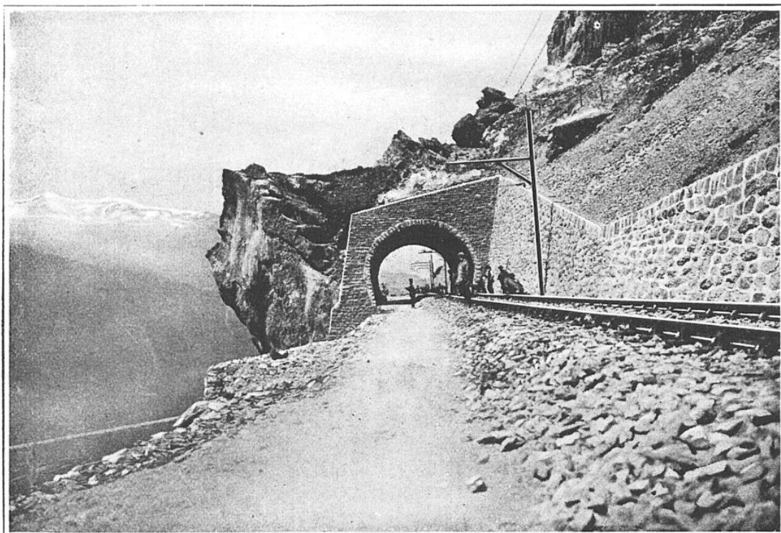
TRAVAUX DE PROTECTION CONTRE LES AVALANCHES ET LES ÉBOULIS AU SUD DU TUNNEL
