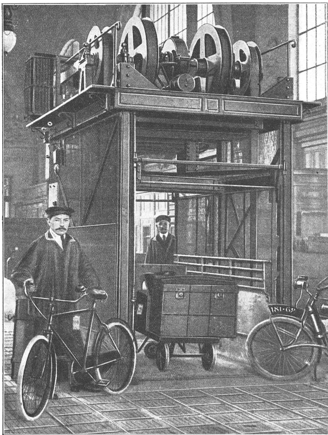
UN DES MONTE-CHARGES ÉLECTRIQUES DE LA GARE DU QUAI D'ORSAY
