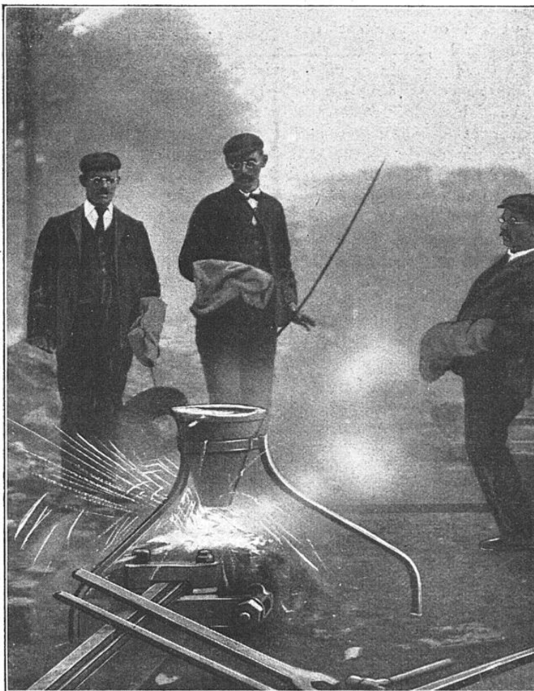
SOUDAGE DE RAILS DE TRAMWAYS
