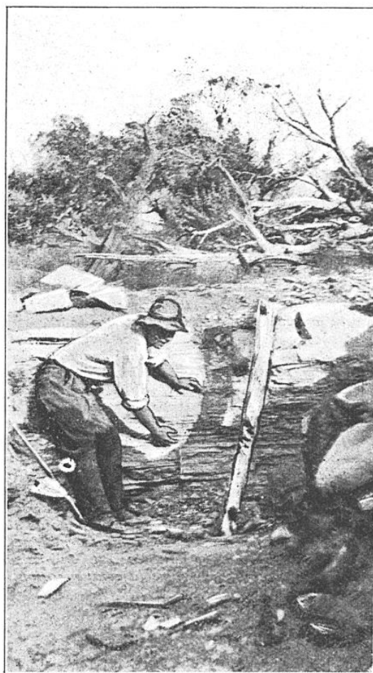
UN GISEMENT RADIOACTIF AU COLORADO La veine mise à nu est presque à fleur de terre et l'extraction du minerai est peu coûteuse. Mais les traitements chimiques très complexes qui conduisent au bromure de radium pur en portent le prix à 400 000 francs le gramme.
