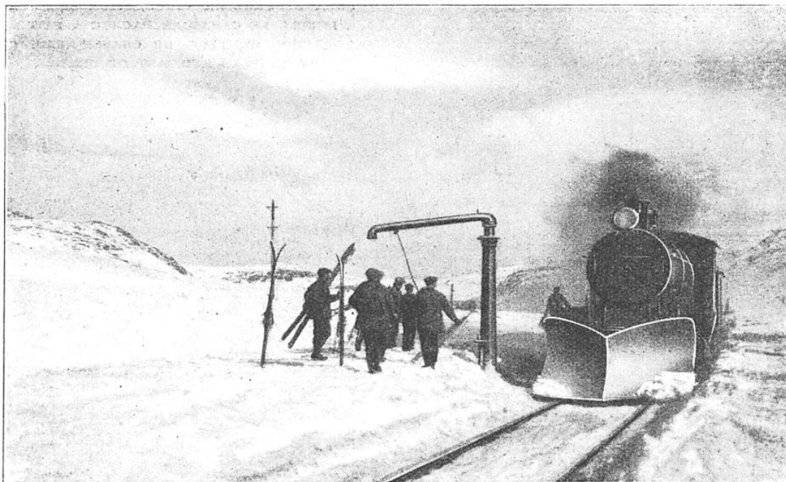
CHASSE-NEIGE DÉMONTABLE ADAPTÉ A UNE LOCOMOTIVE
