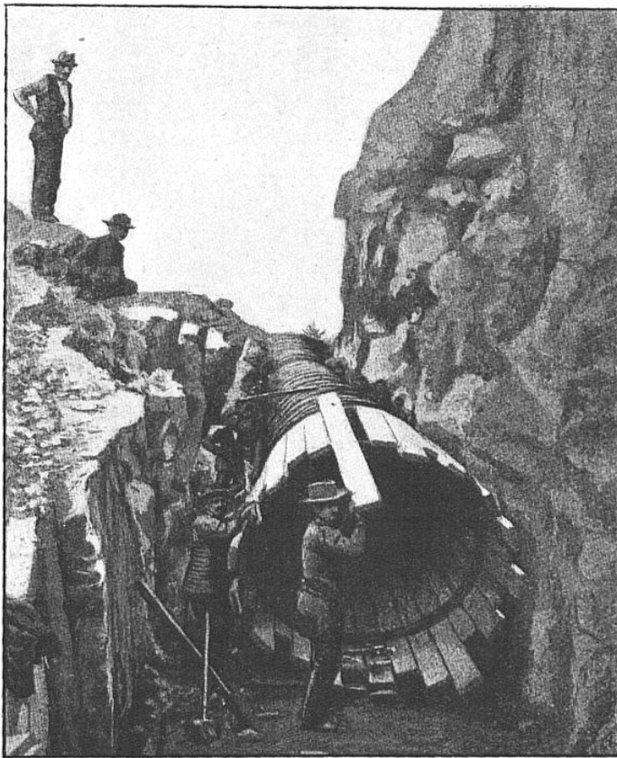
On fait franchir aux conduites des montagnes granitiques où des tranchées sont creusées à la dynamite.
