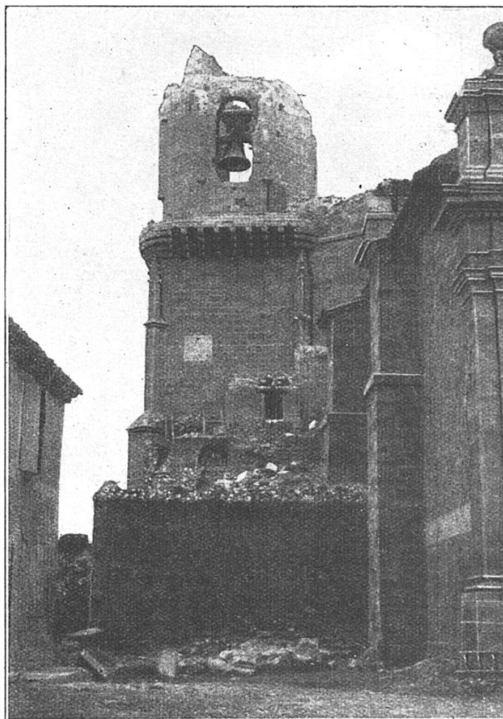
LA FLÈCHE DE CE CLOCHER A ÉTÉ JETÉE A BAS PAR LES SECOUSSES DU SOL
