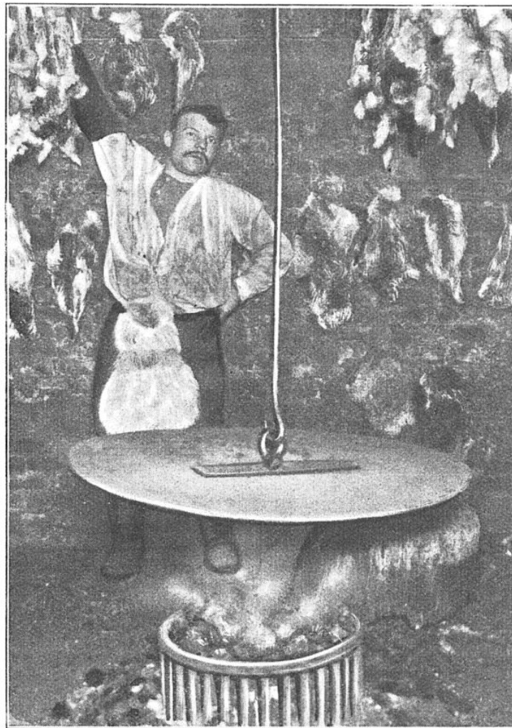
UNE ÉTUVE RUDIMENTAIRE POUR LE SÉCHAGE DES PEAUX
