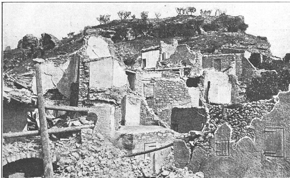
A COTÉ DES HABITATIONS, RUINÉES PAR LE SÉISME, LA NATURE DEMEURE IMPASSIBLE L'aspect désolé de ce village de Provence après le tremblement de terre forme un contraste frappant avec la végétation de la colline voisine, que le cataclysme semble avoir épargnée
