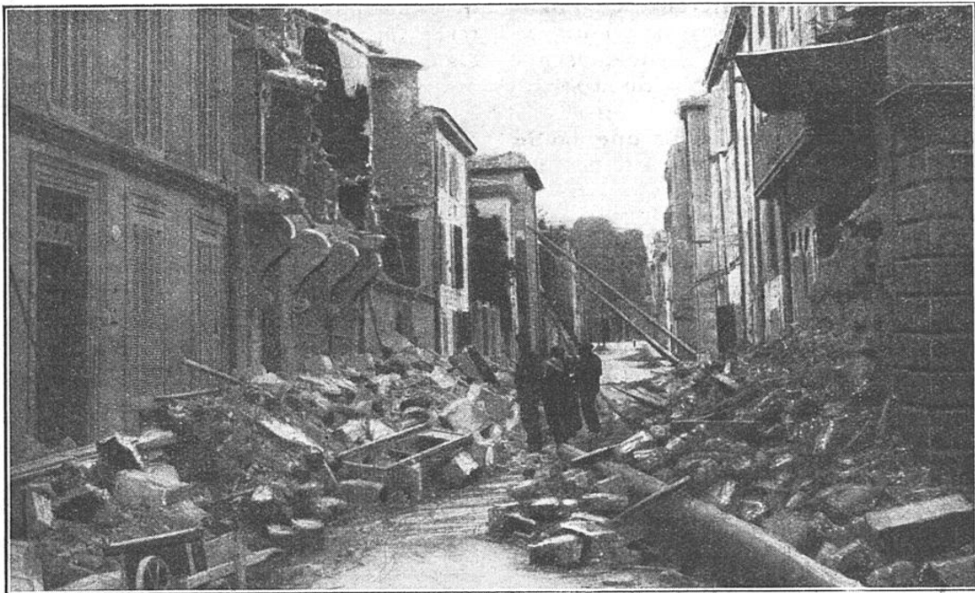
QUELQUES TRACES DU DERNIER TREMBLEMENT DE TERRE DE PROVENCE (11 JUIN 1909) A Salon, les maisons de la rue d'Avignon avaient fortement souffert : les murs qui ne s'étaient pas écroulés durent être étayés pour maintenir leur équilibre incertain.
