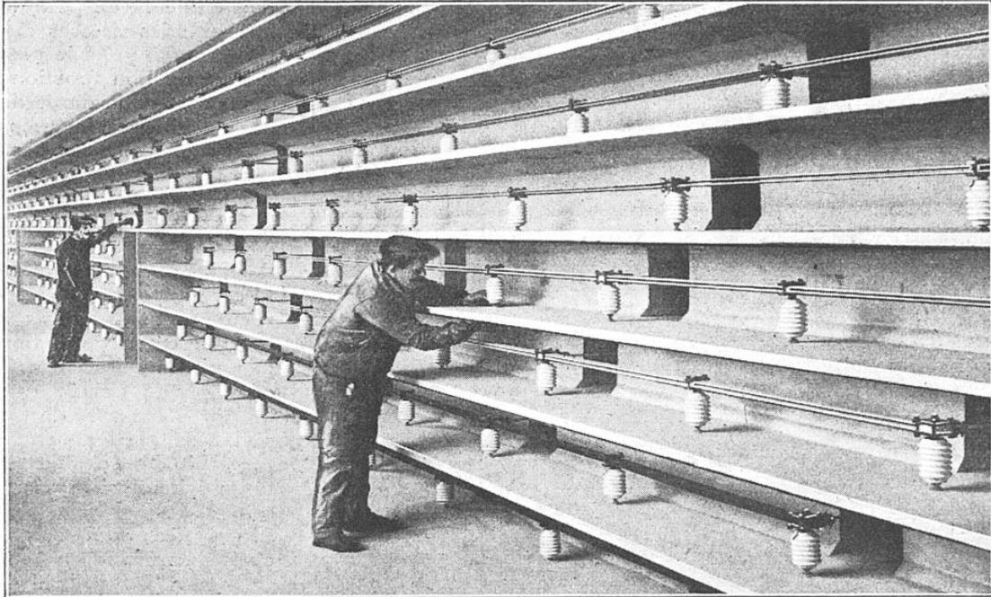
C'EST PAR CES BARRES QUE S'ÉCOULE L'ÉNERGIE ÉLECTRIQUE PRODUITE PAR LA CENTRALE.
