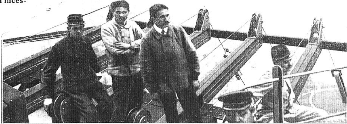
ACCROCHAGE DES FILS D'ANTENNE AU SOMMET DE LA TOUR EIFFEL.
