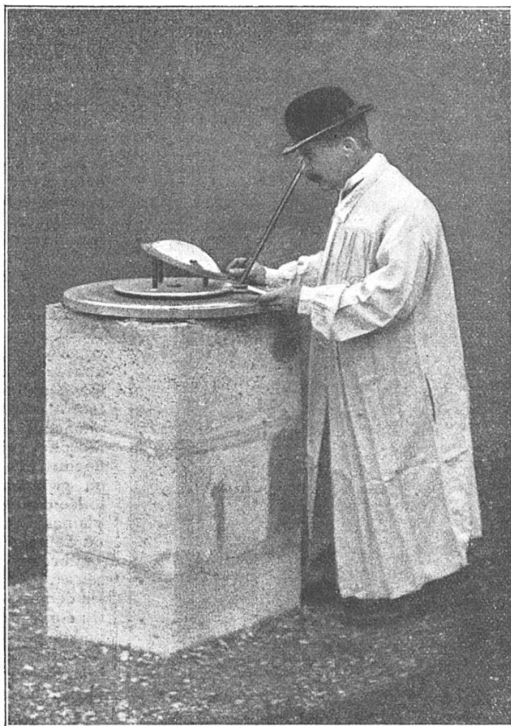
LA NÉBULOSITÉ ÉTUDIÉE A L'AIDE DU NÉPHOMÈTRE
