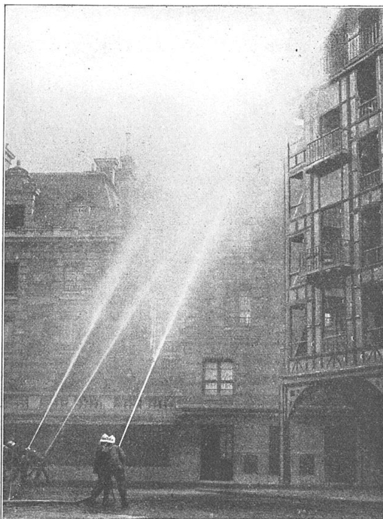
POMPIERS PARISIENS MANŒUVRANT TROIS GROSSES LANCES
