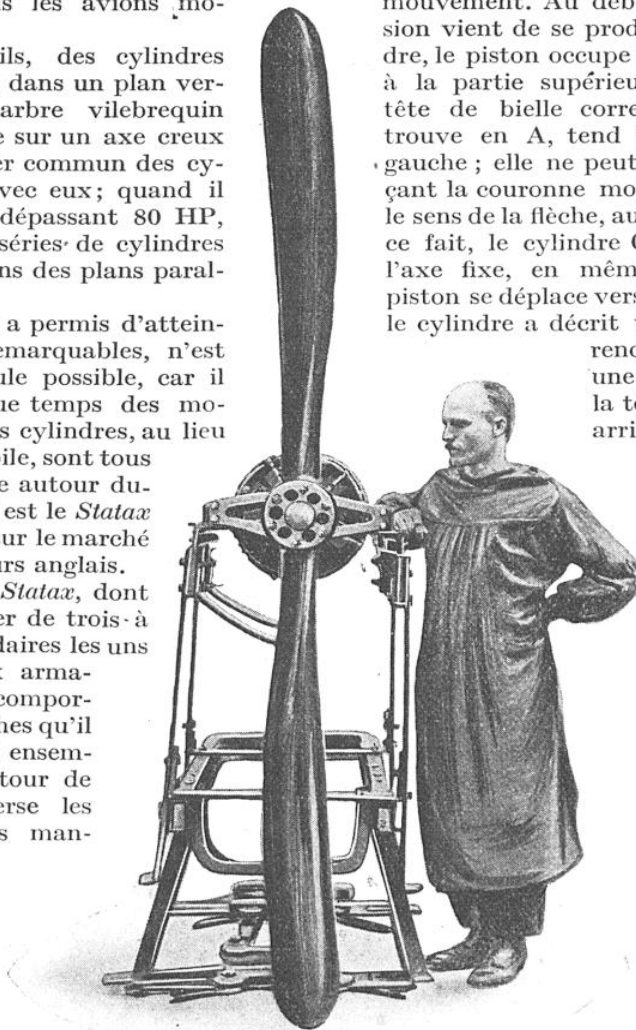
MOTEUR STATAX ATTELÉ A UNE HÉLICE D'AVION
