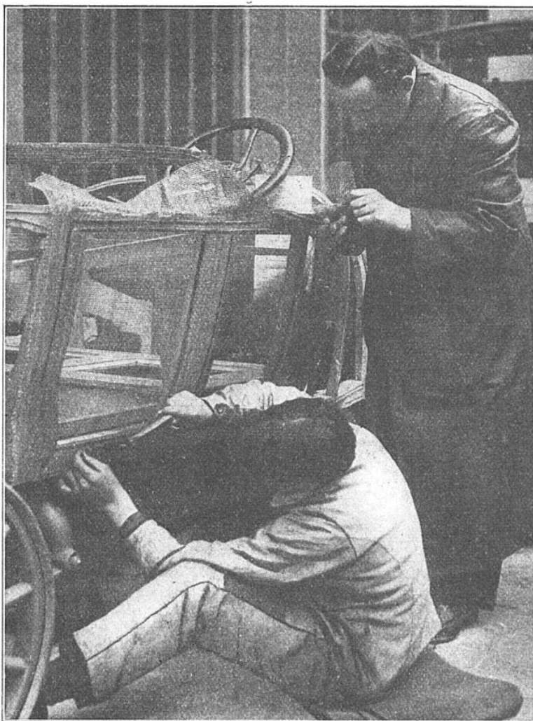
POSE DE LA TOILE MÉTALLIQUE SUR LA CARCASSE
