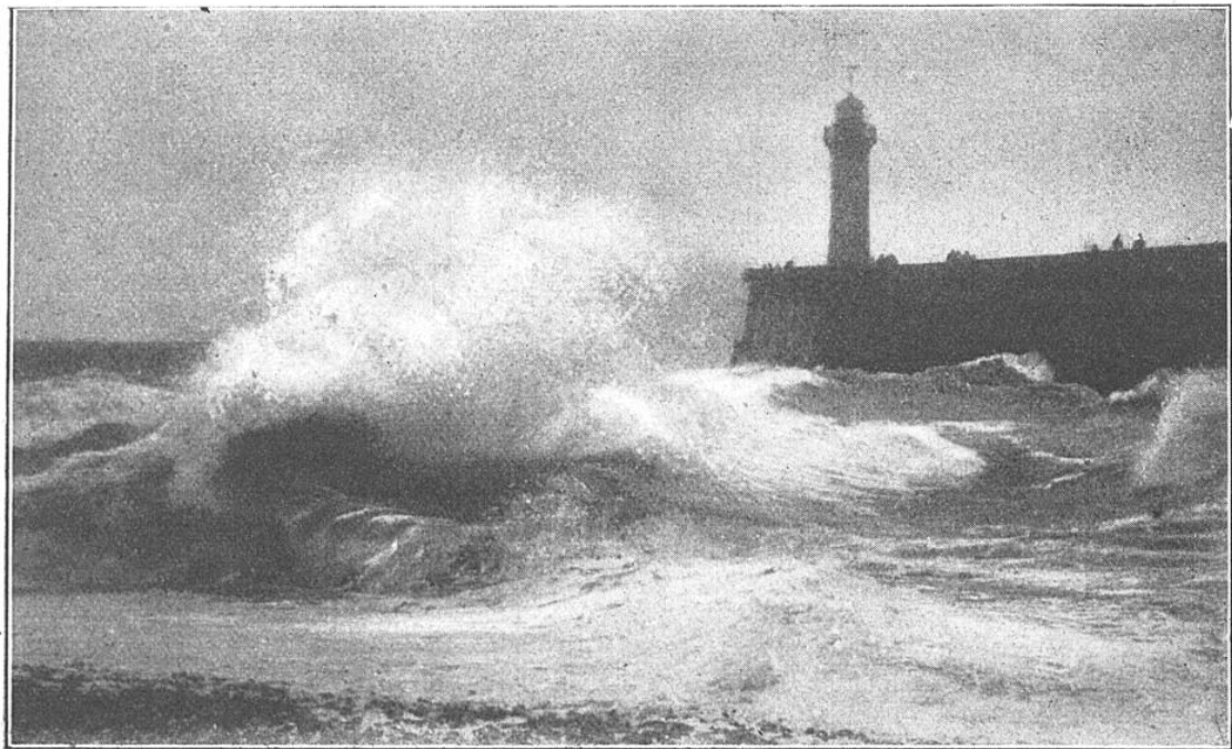
LA RENCONTRE DE L' « ONDE D'ARRIVÉE » AVEC L' « ONDE DE RETOUR » La masse d'eau se retire après avoir heurté la jetée; en redescendant, elle rencontre et frappe à la base les nouvelles lames qui arrivent; ces dernières, de ce fait, déferlent plus vite.
