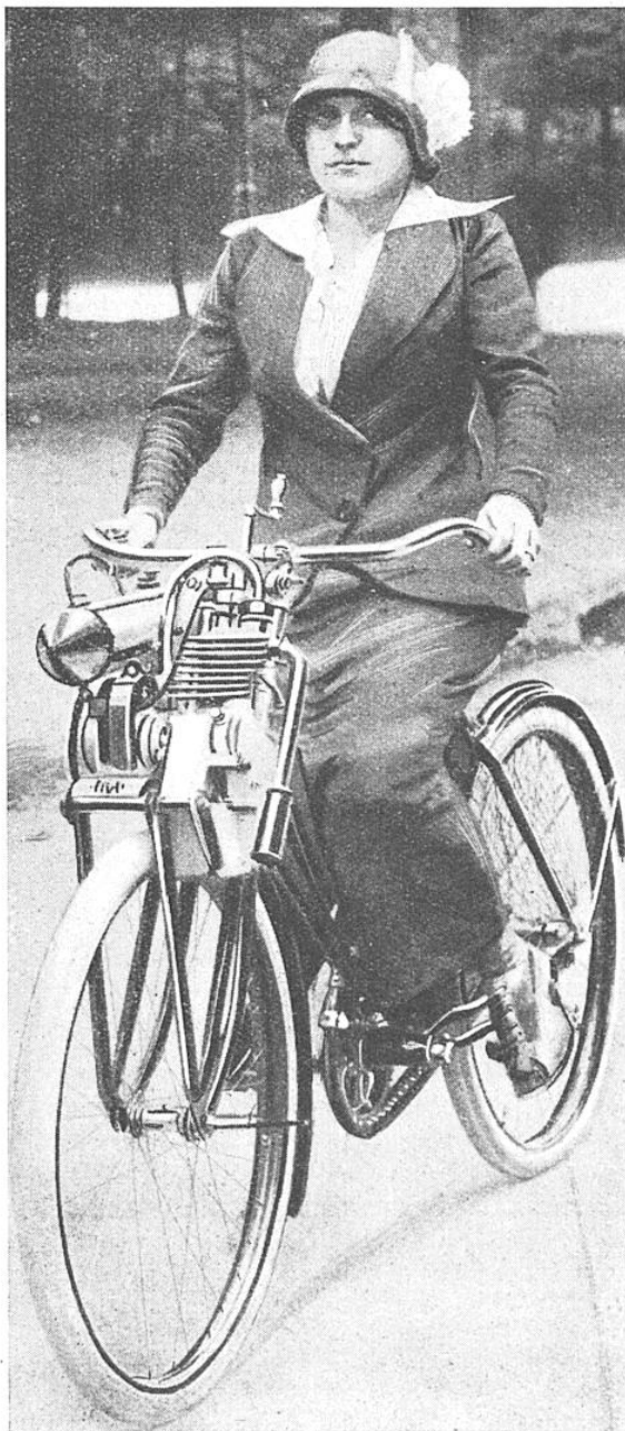
CETTE CYCLISTE N'A PAS BESOIN DE PÉDALER Le mototracteur adapté sur une bicyclette ordinaire la transforme en motocyclette tout en lui conservant ses qualités de légèreté et de souplesse.
