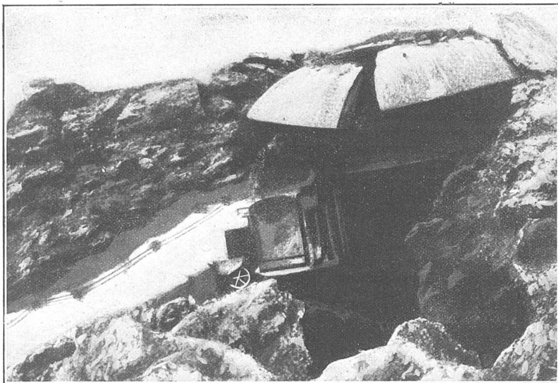
UNE COUPOLE CUIRASSÉE DU FORT DE FLÉRON APRÈS LE BOMBARDEMENT
