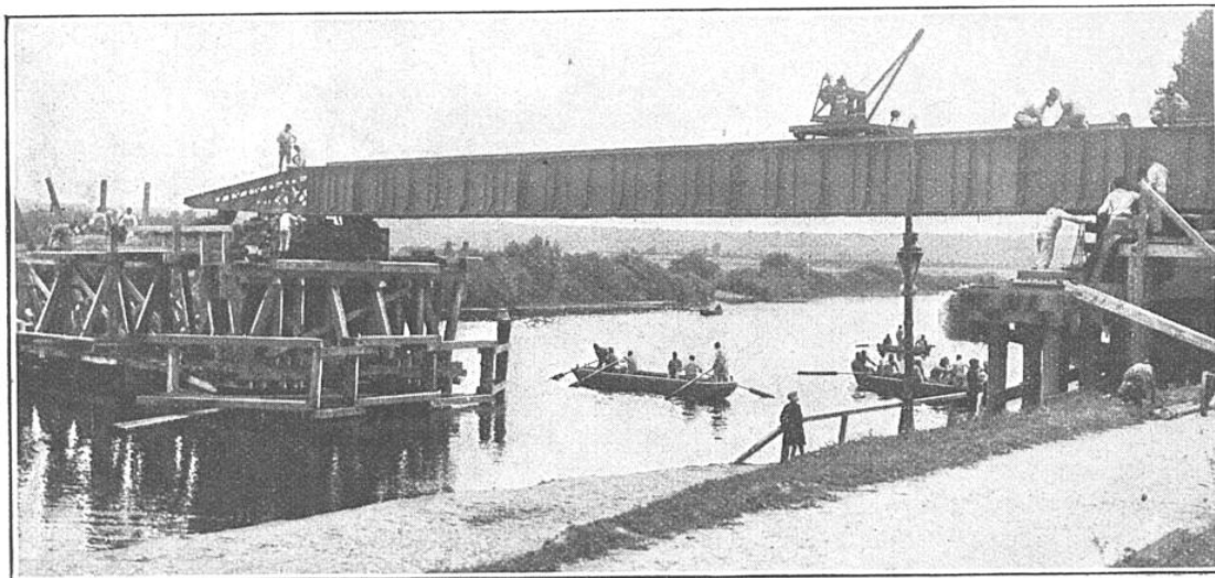
LE GÉNIE FRANÇAIS LANÇANT UN PONT SUR LA MARNE, EN AVANT DE MEAUX
