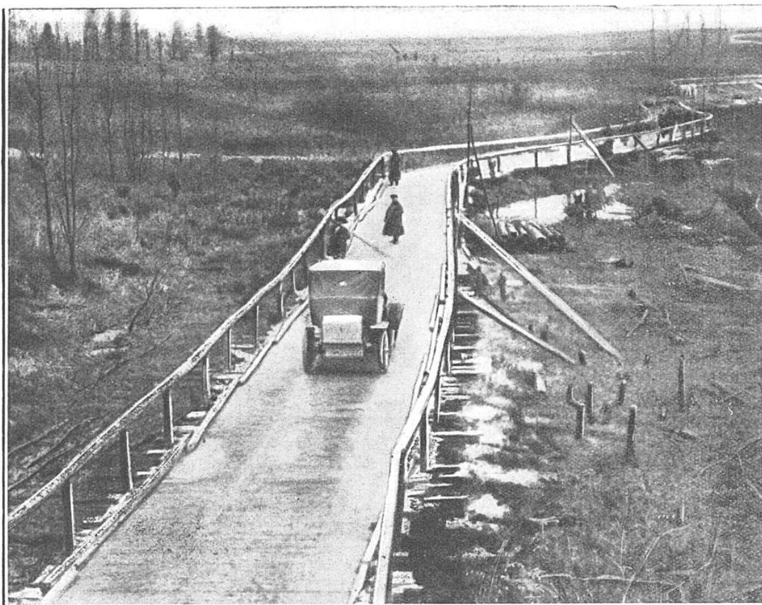
PONT DE BOIS DE 500 MÈTRES CONSTRUIT PAR LES ALLEMANDS AU-DESSUS D'UN MARAIS
