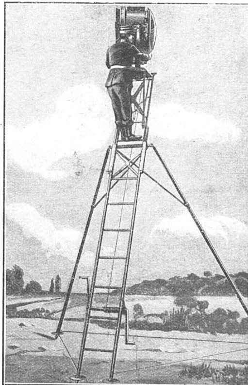
PROJECTEUR DE 60 cm SYSTÈME SAUTTER-HARLÉ, EMPLOYÉ DANS L'ARMÉE FRANÇAISE
