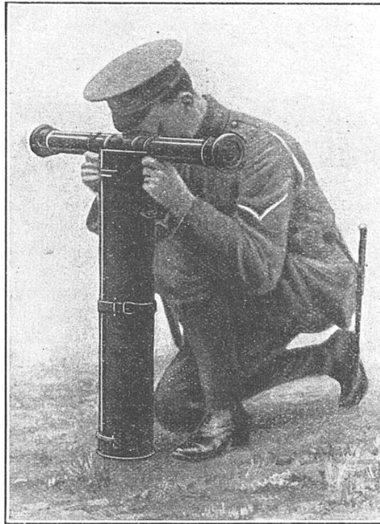
LA POSITION A GENOUX DU TÉLÉMÉTRISTE L'étui du télémètre de campagne peut former, comme on le voit, un pied très stable pour l'instrument.
