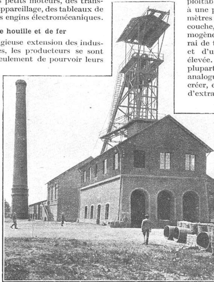
HOUILLÈRE DE DECIZE (PUITS DES MINIMES)
