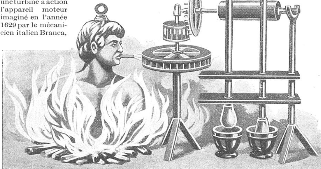
LA PREMIÈRE TURBINE A ACTION, INVENTÉE EN 1629 PAR BRANCA
