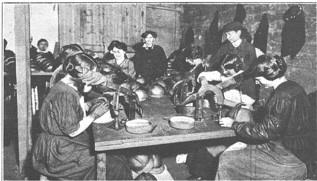
RIVETAGE DU CIMIER SUR LA BOMBE AU MOYEN DE QUATRE RIVETS D'ALUMINIUM.
