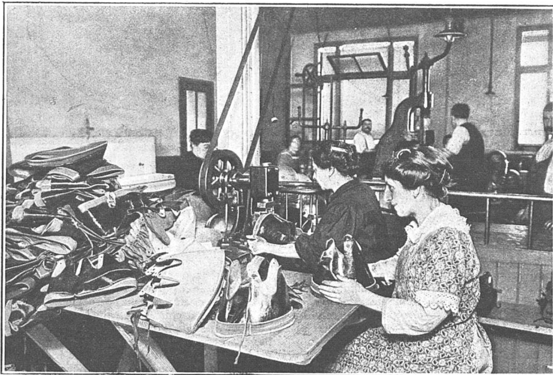
LE PERÇAGE DES TROUS DANS LE TURBAN DE LA COIFFE
