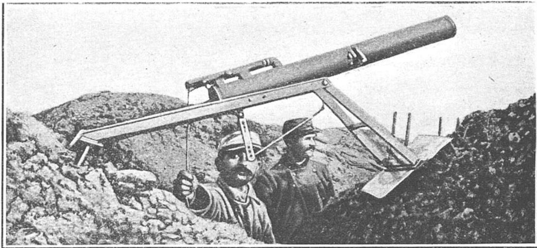
LANCE-BOMBES FRANÇAIS MONTÉ SUR UN CHASSIS PERMETTANT LE POINTAGE
