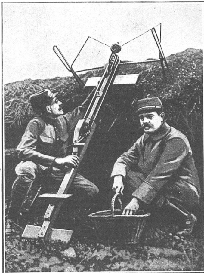
AVEC CETTE ARBALÈTE, QUE NOS HOMMES APPELLENT " SAUTERELLE ", ON PROJETTE DES GRENADES A UNE DISTANCE DE 80 MÈTRES ENVIRON
