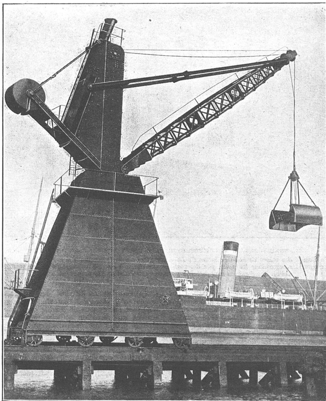
GRUE HYDRAULIQUE ROULANTE POUR LA MANUTENTION DU CHARBON
