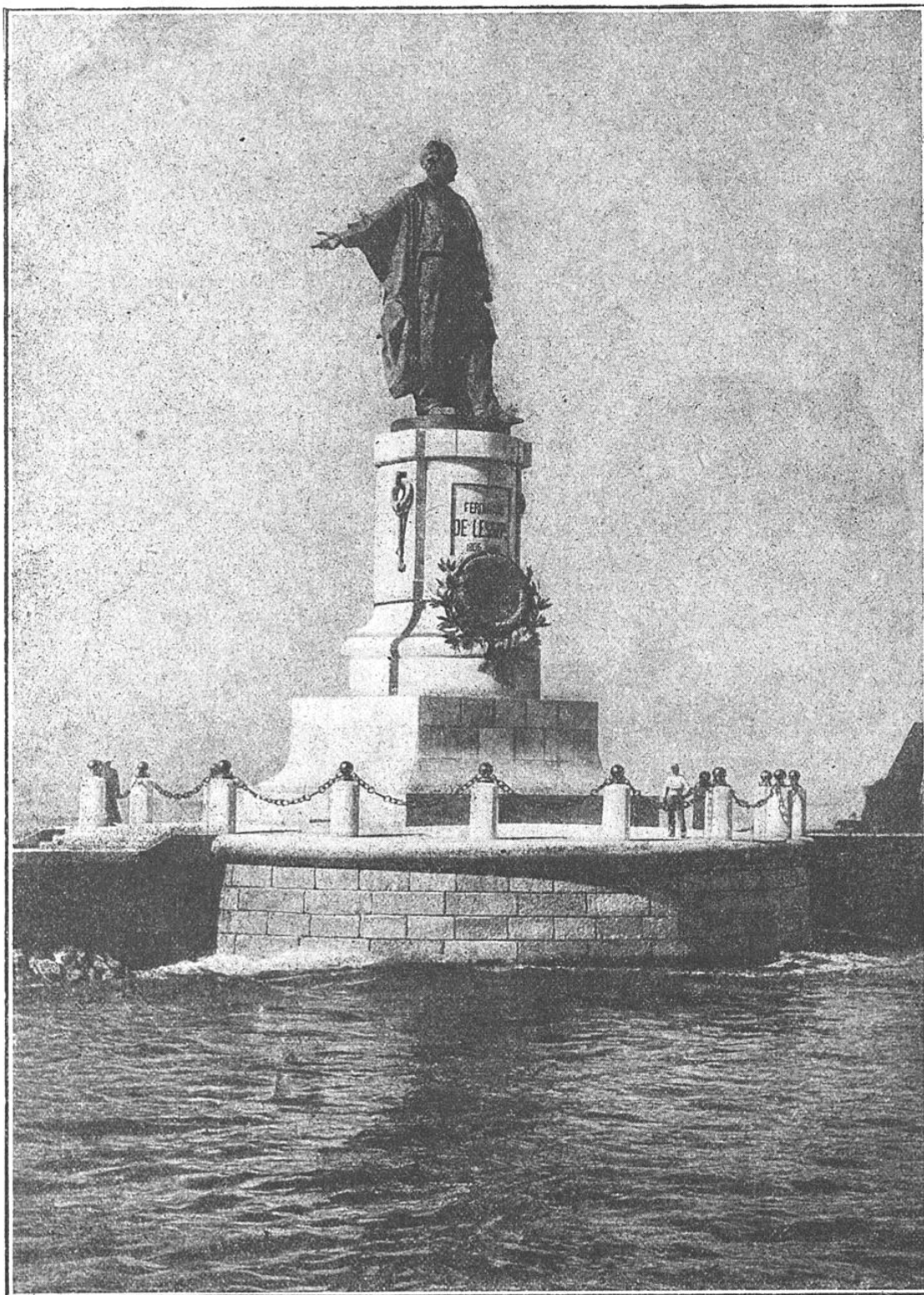
LE MONUMENT DE FERDINAND DE LESSEPS, CRÉATEUR DU CANAL DE SUEZ, A PORT-SAÏD
