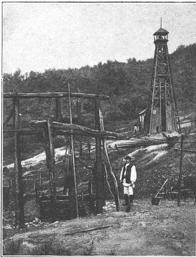
FONÇAGE D'UN PUIT DE PÉTROLE PAR LE VIEUX PROCÉDÉ ROUMAIN
