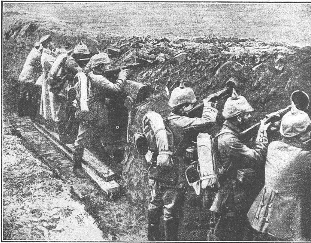
TRANCHÉE AVEC PARAPET EXHAUSSÉ MUNI DE CRÉNEAUX EN POTERIE
