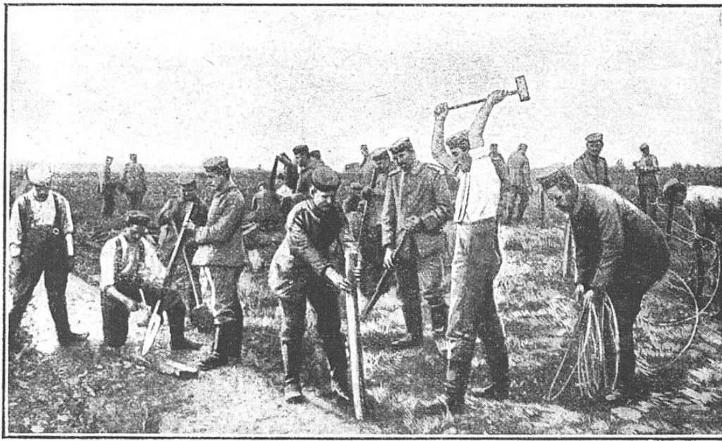
PIONNIERS ALLEMANDS ÉTABLISSANT UN RÉSEAU DE FILS DE FER BARBELÉS
