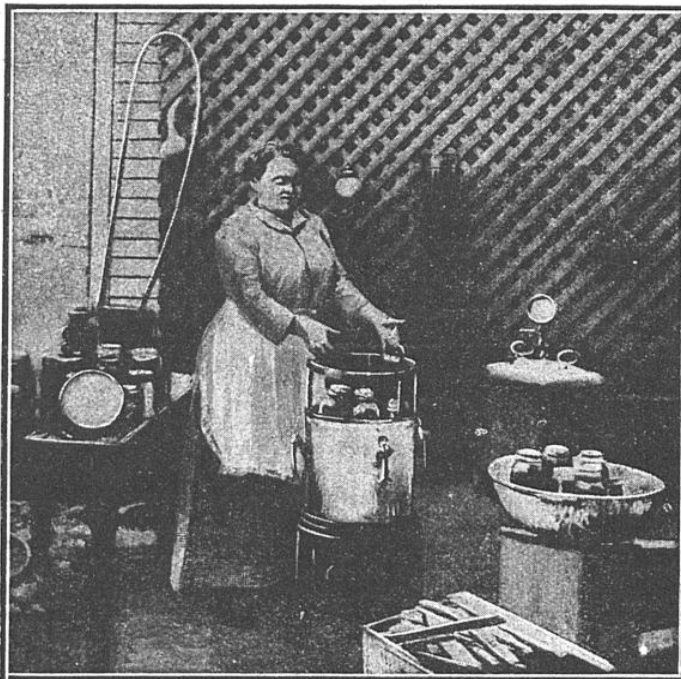
BOITES DE CONSERVES PLACÉES DANS LE PANIER DE L'AUTOCLAVE POUR ÊTRE STÉRILISÉES
