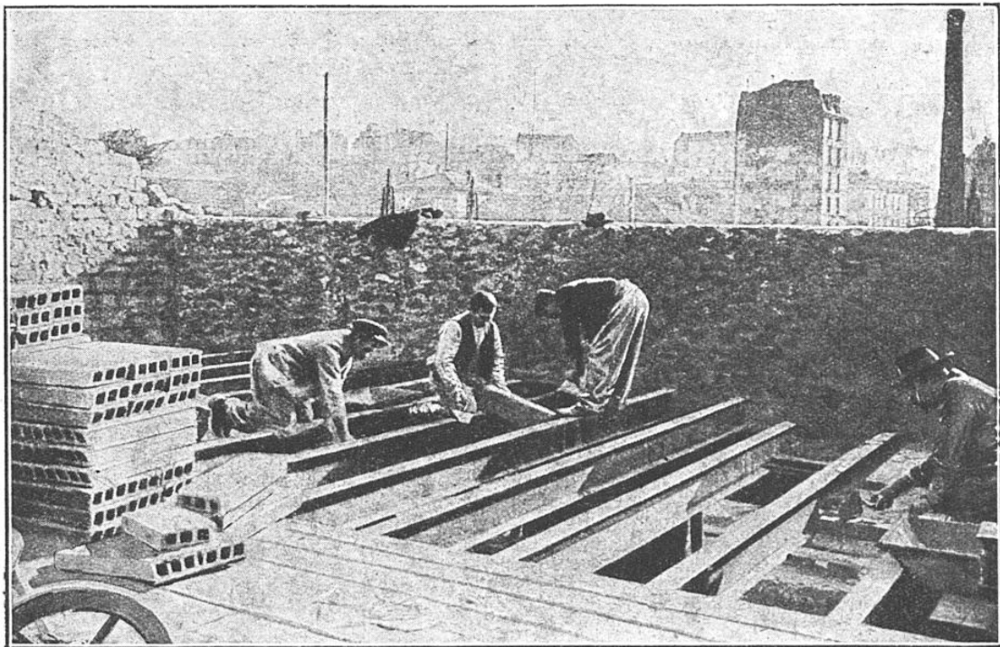
SYSTÈME DE CONSTRUCTION D'UN PLANCHER EN POUTRELLES D'ACIER
