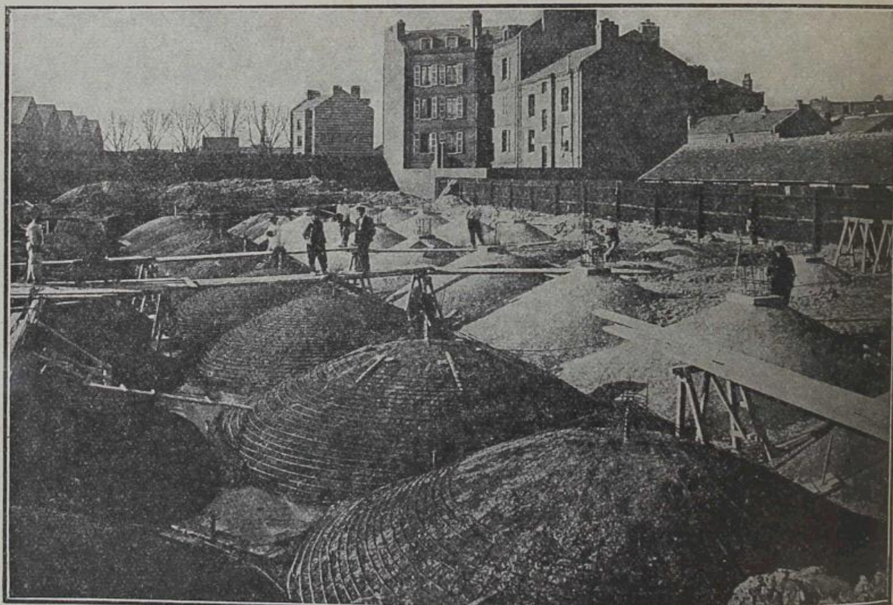
VUE D'UN CHANTIER DE FOUILLES OU SONT PRÉPARÉES DES FONDATIONS CONIQUES
