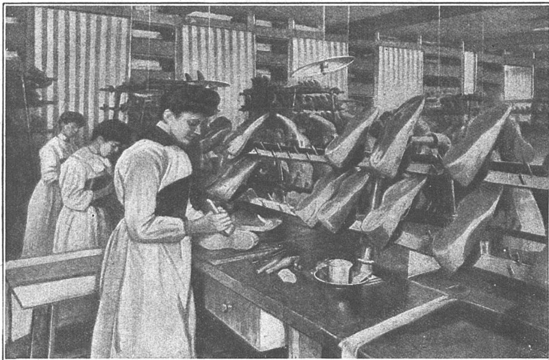
ATELIER DE MONTAGE DES GALOCHES DE TRANCHÉES, EN CAOUTCHOUC Les chaussures imperméables destinées à nos soldats subissent le dernier apprêt avant d'être vulcanisées
