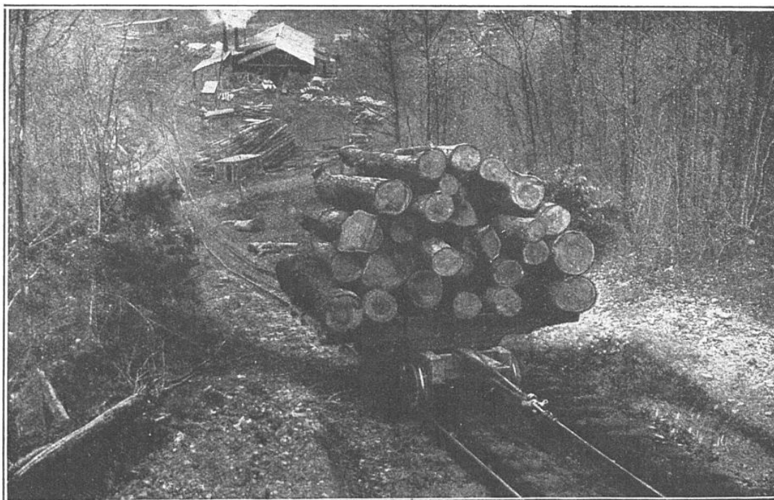
WAGONNET CHARGÉ DE BOIS EN GRUME DESCENDANT SUR UN PLAN INCLINÉ
