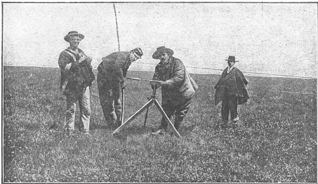
MESURE D'UNE BASE GÉODÉSIQUE AU MOYEN DU FIL JADERIN
