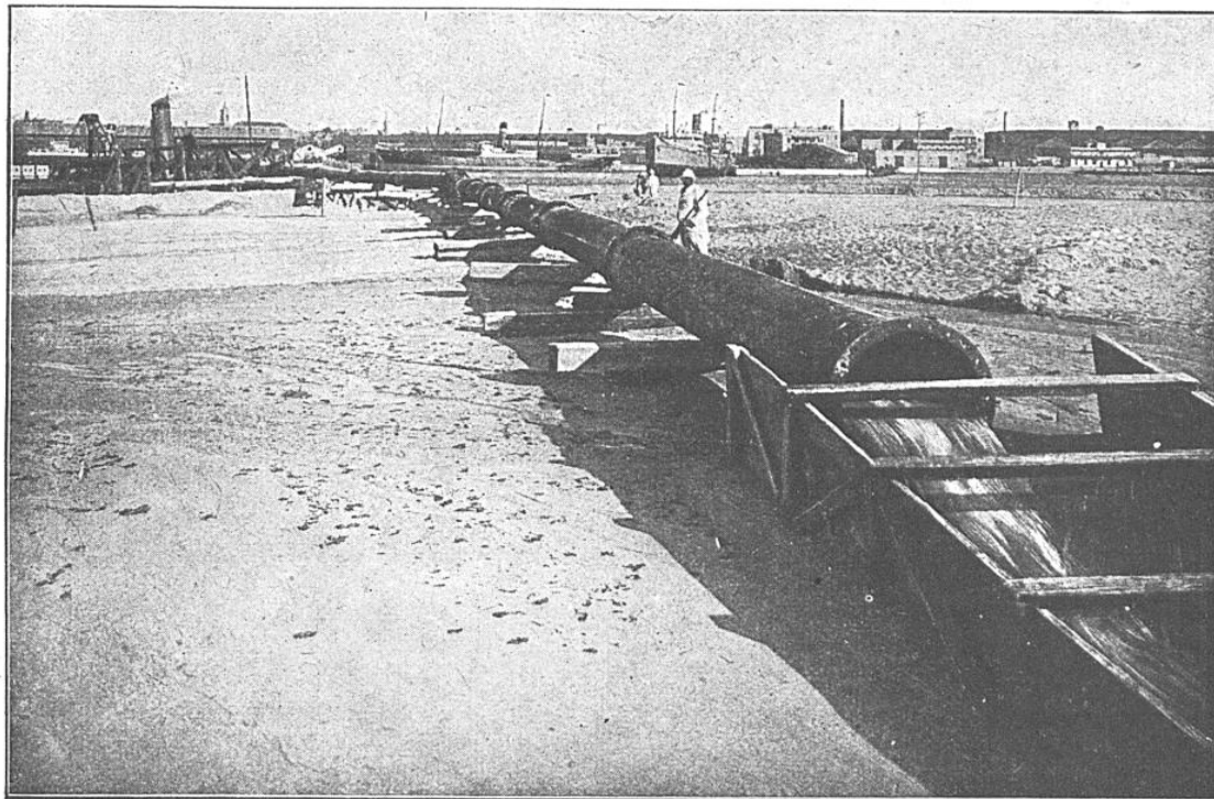
TUYAU D'ÉVACUATION D'UNE DRAGUE TRAVAILLANT DANS UN CANAL
