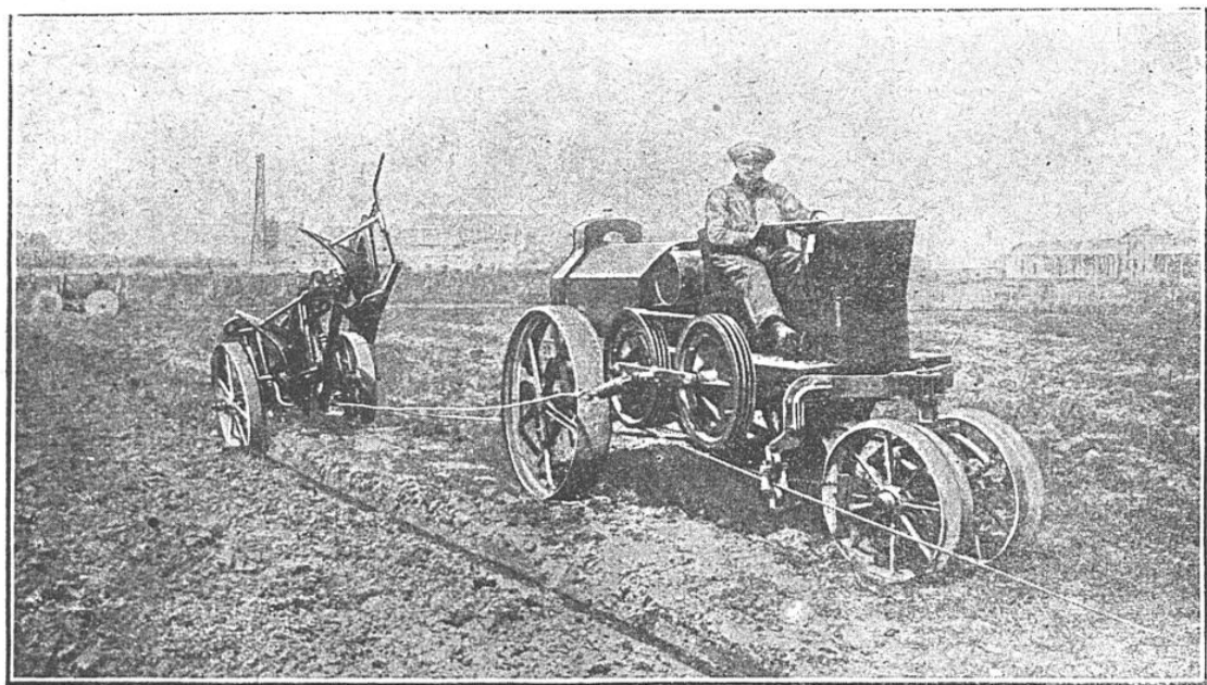
TRACTEUR-TOUEUR FILTZ REMORQUANT UNE CHARRUE A BASCULE
