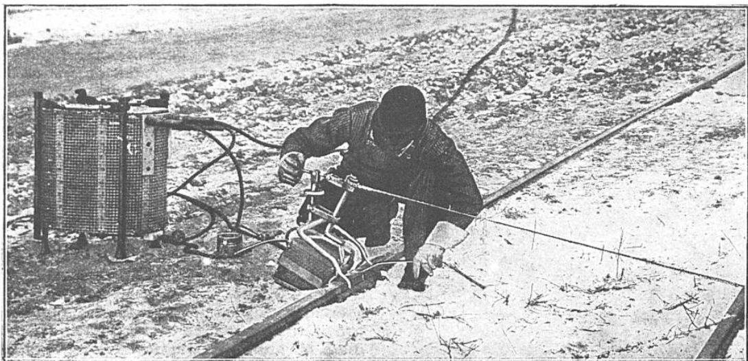
AVEC CE PETIT APPAREIL, UN HOMME SUFFIT POUR EXÉCUTER LES SOUDURES
