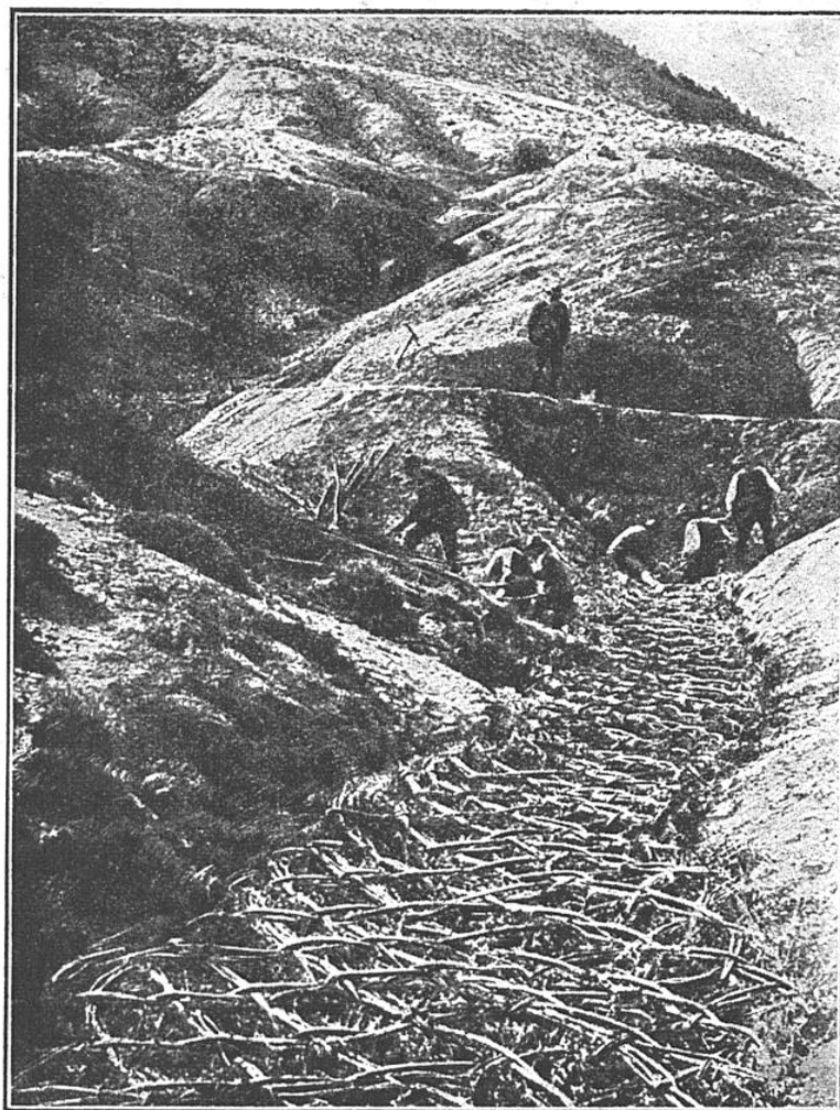
GARNISSAGE D'UN RAVIN DANS LES BASSES-ALPES
