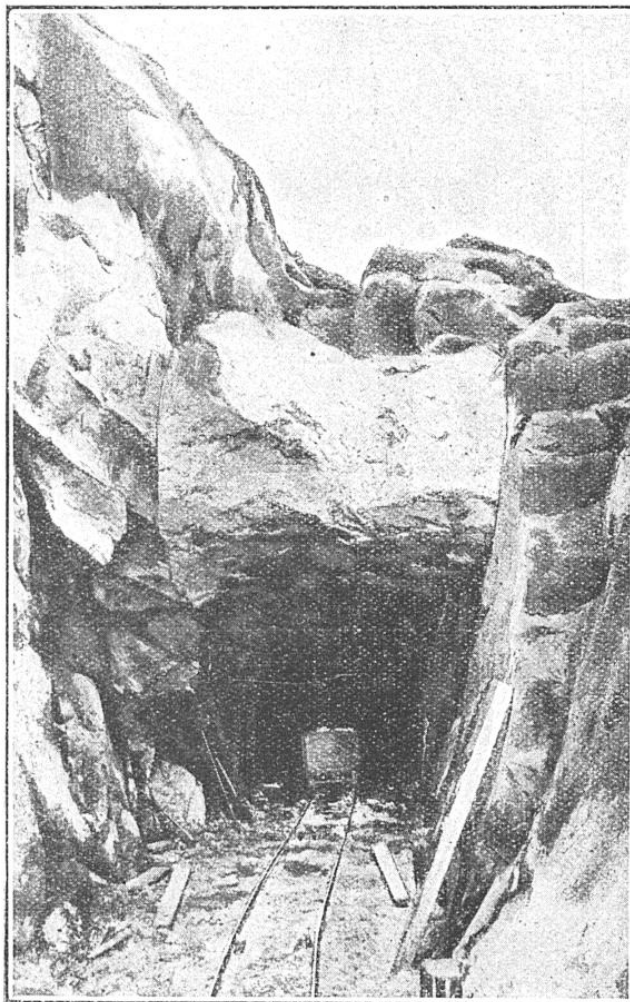
MÉTHODE D'EXPLOITATION D'UN DYKE DE FELDSPATH-ORTHOSE, A MOSKEN, DANS LES ILES LOFODEN (NORVÈGE)
